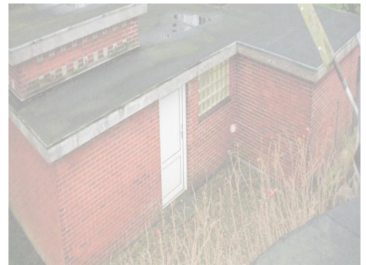
Asserballe Vandværk anno 1972
